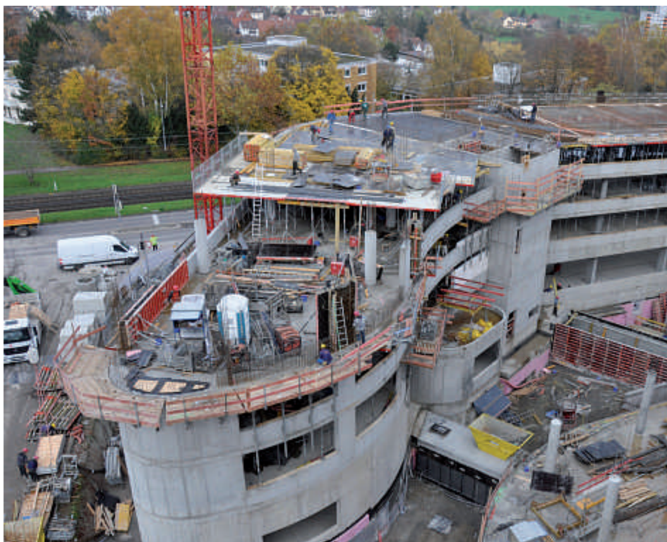
Das aktuelle Bild von der Baustelle der DRV.
