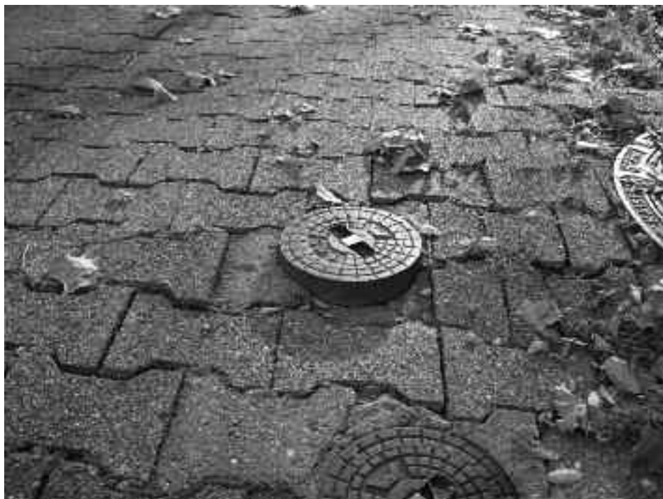
Bild Nr. 6: Stolperfalle - vorher
