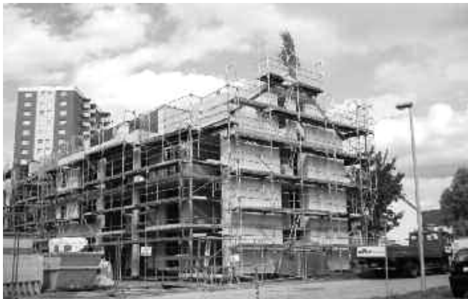
Der Neubau der BG Neues Heim an der Hechtstraße/Ecke Flundernweg beim Richtfest am 16.09.2010
