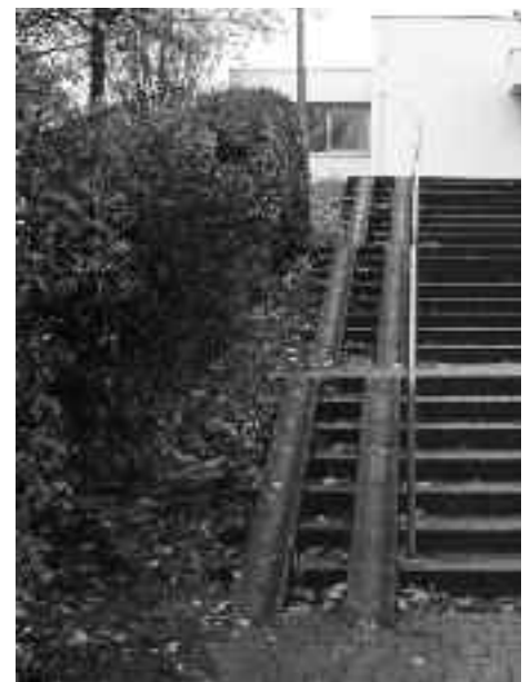
Bild Nr. 5: Treppe - nachher
