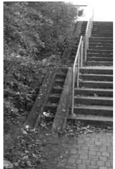
Bild Nr. 4: Treppe - vorher
